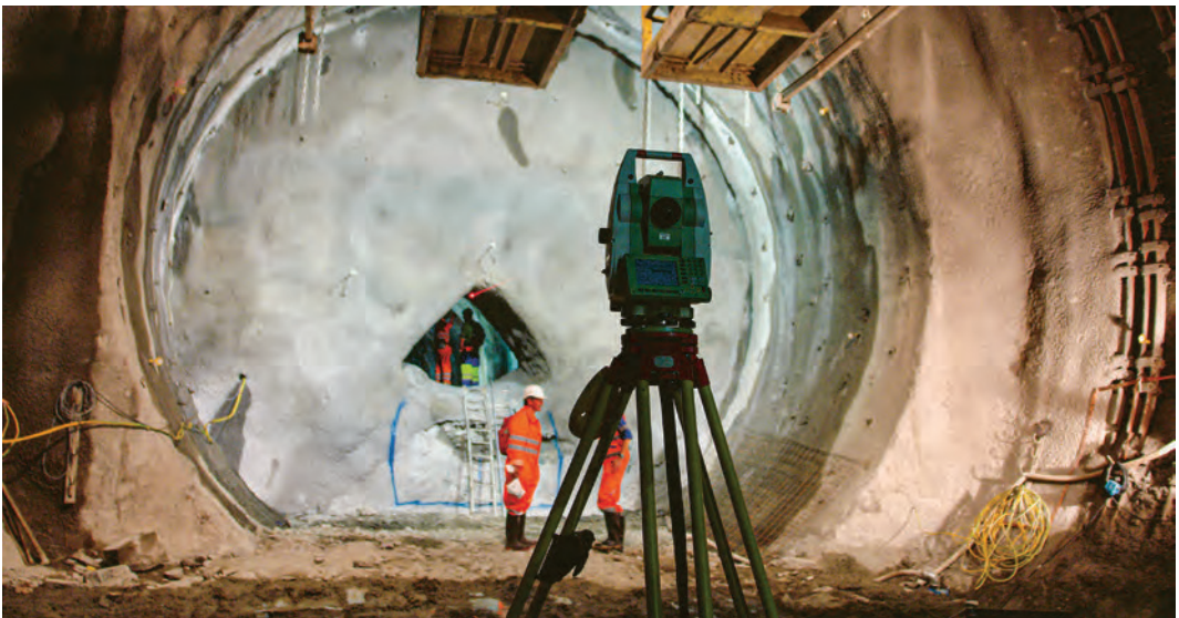
Beim Bau des 57 Kilometer langen Gotthardbasistunnels kamen verschiedene Leica Geosystems-Instrumente zum Einsatz, zum Beispiel Digitalnivelliere. Die Abweichung auf die gesamte Distanz betrug nur wenige Zentimeter.
